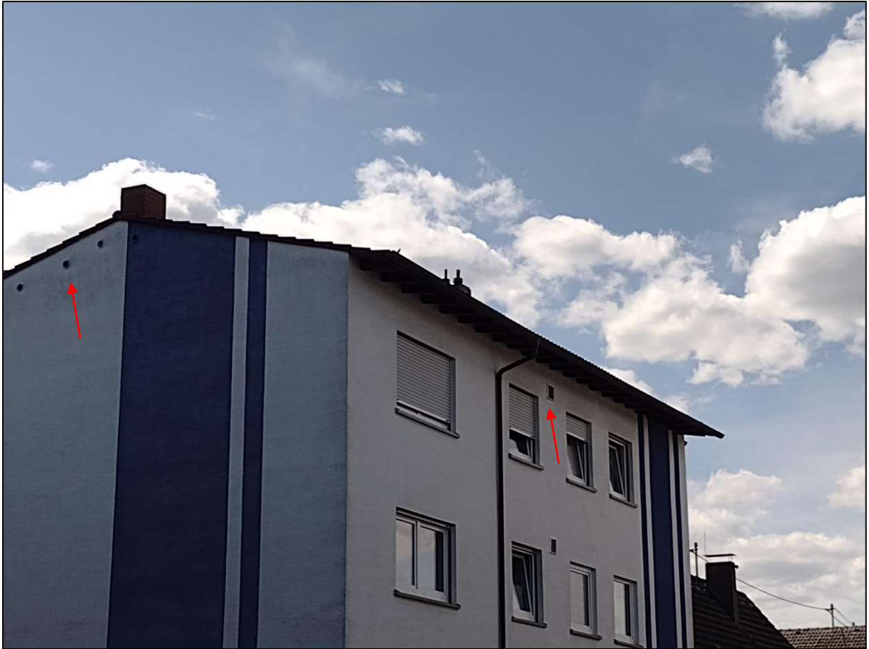
Abb. 6: Bestandgebäude mit Lüftungsschlitz und -röhren in der Fassade. (IBU, 2023)
