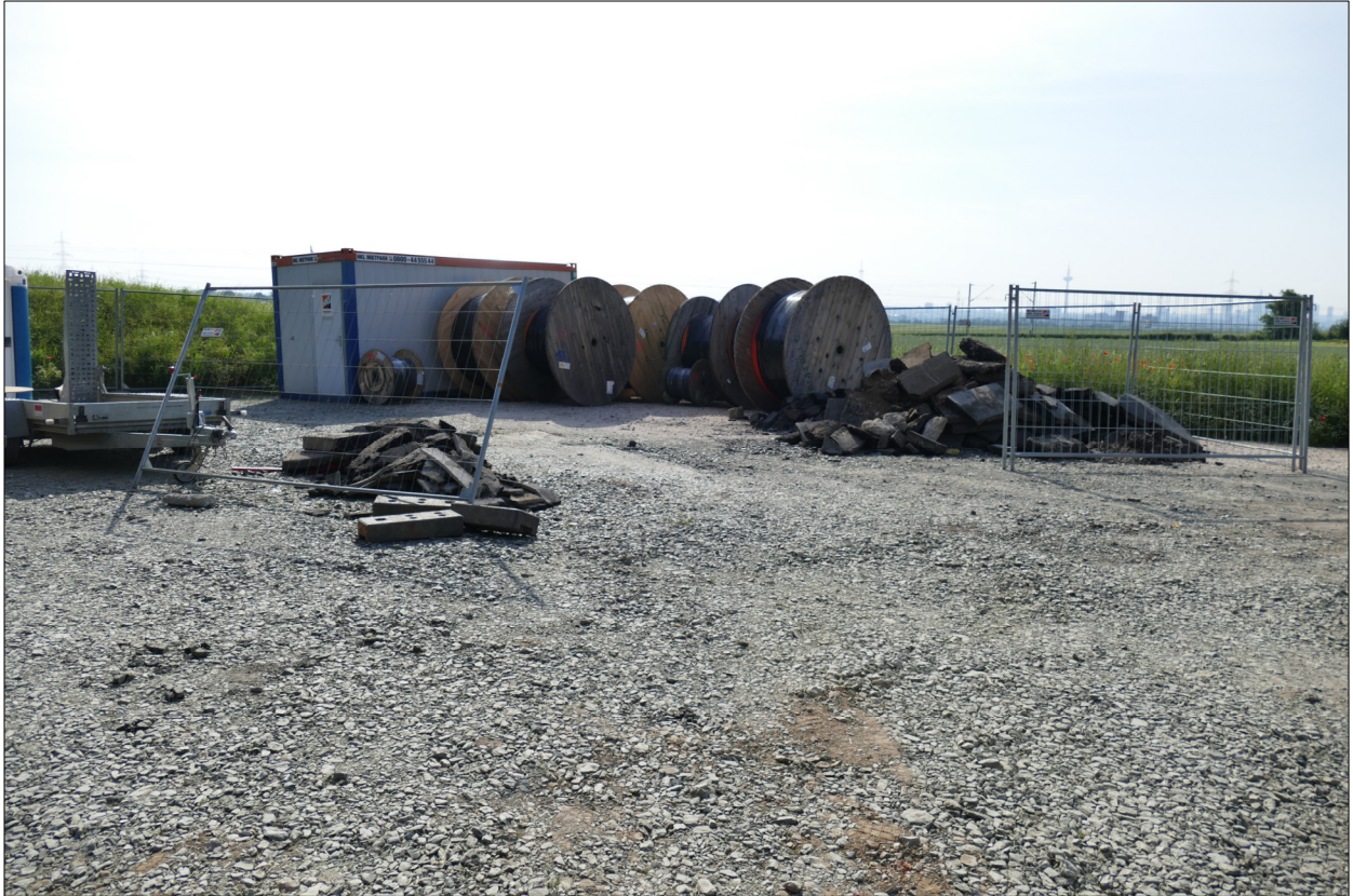
Abbildung 12: Blick von der Industriestraße auf den westlichen Teil der geschotterte Baustelleneinrichtungsfäche.
