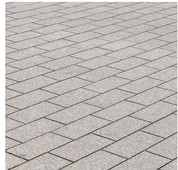
Betonstein, Reihenverband
