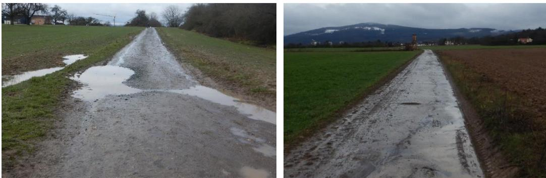
Der erste Teil der Wirtschaftswegeverbindung ist mit einer wassergebundenen Decke ausgebaut, der zweite Teil mit Betonplatten. Die gesamte Verbindung verfügt über keine funktionierende Entwässerung und schadhafte Oberflächen.
