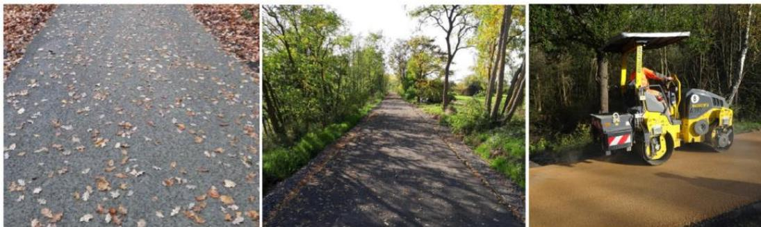
**Abbildung 4: Asphaltähnliche Deckschichten aus Gemisch von Basaltstein und Spezialsanden / heller Split-Mastix-Asphalt**
