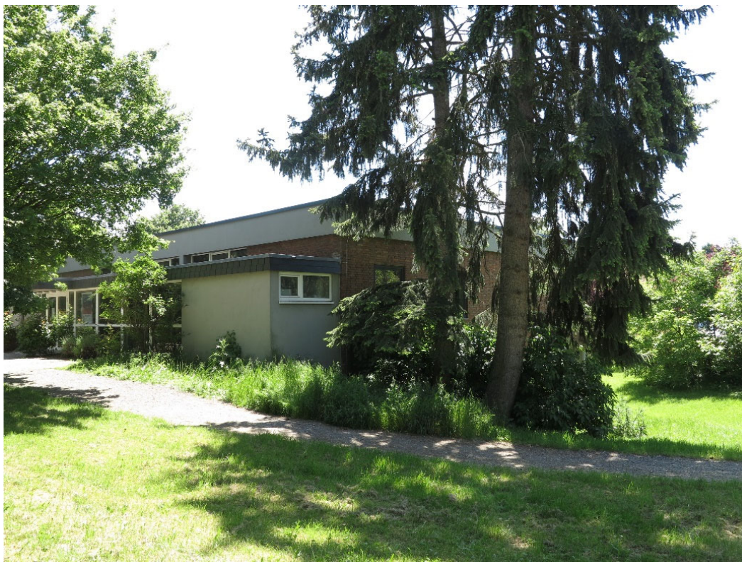
Abb. 7: Westlicher Eingriffsbereich seitlich des Bestandsgebäudes
