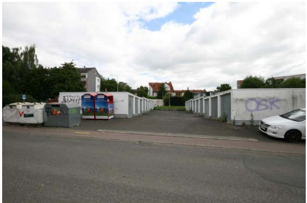
Garagenplätze am Hessenring
